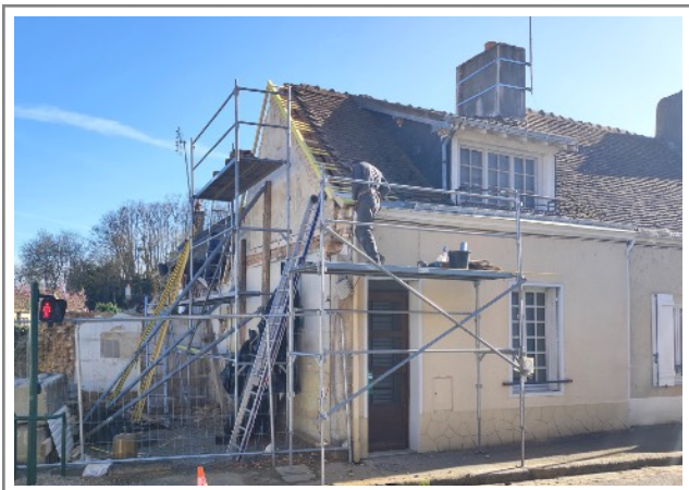
Les travaux de reprise de la toiture sont désormais achevés.
