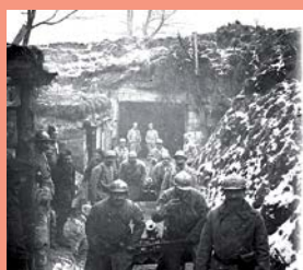
Sortie de pièces d'artillerie de tranchée du cavage d'Ecafauf.
