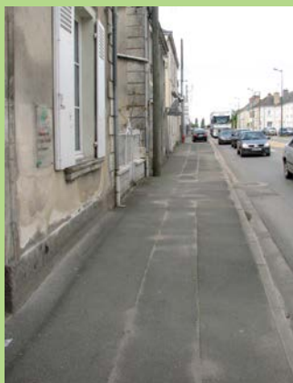
Avenue de la Division Leclerc avant les travaux
